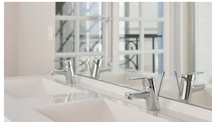
> Salle de bains équipée avec meuble vasque, sèche-serviettes, miroir avec luminaire décoratif
