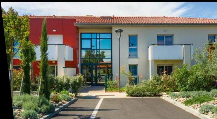
1 VILLENEUVE-TOLOSANE—31 Résidence Terralosa
